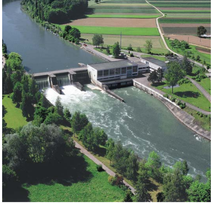
Kraftwerk Aarberg an der Aare.
