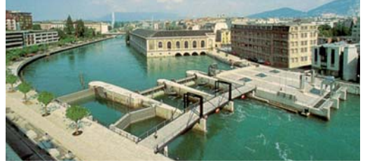
Le barrage du Seujet.
